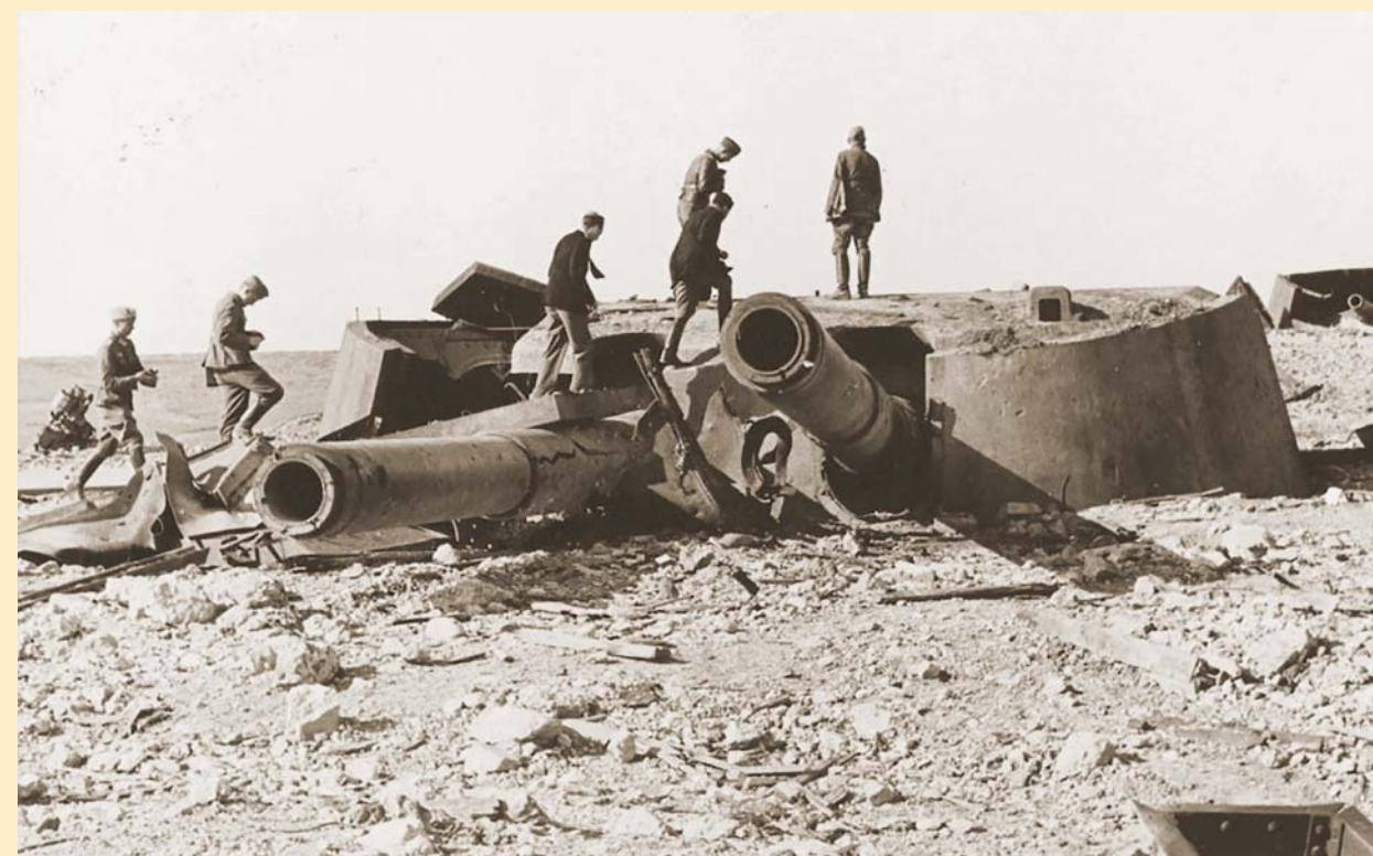
Немецкие военнослужащие осматривают разрушенную 305-мм башню №2 30-й батареи
